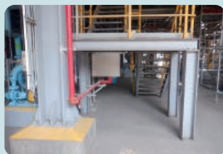
改善後：伴熱柱切除，將需要的伴熱管移至其它伴熱柱
