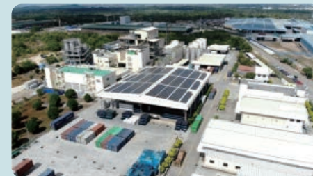
大連化工馬來廠太陽能發電裝置
