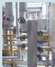
重新整合後的伴熱柱採用 304 材質
